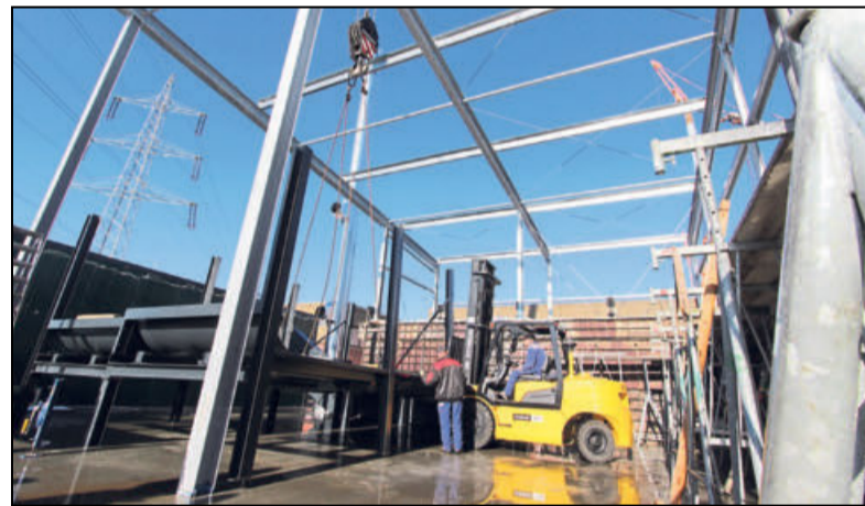
Der 33 Tonnen schwere und 4,30 Meter breite Heizcontainer wurde mit einem Schwerlasttransporter zum Hallenbad gebracht.
