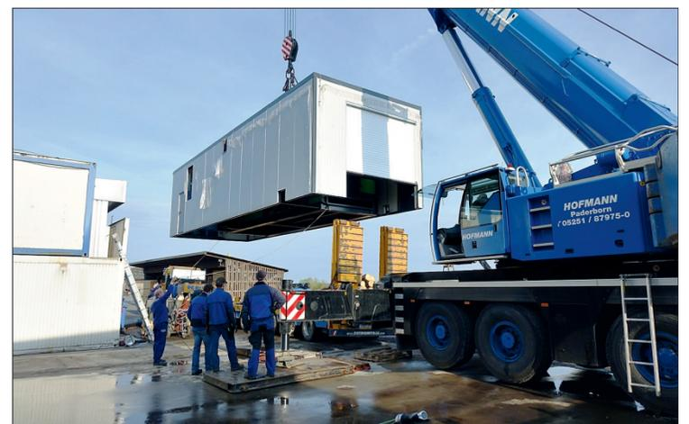
Der Container mit Gesamtanlage wird vom Tieflader gehoben
