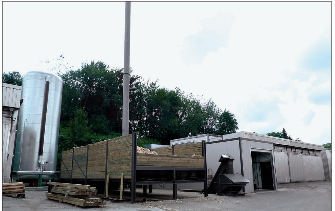
Die Anlage mit Kessel im Container, Brennstoffbunker, Pufferspeicher und Kamin passt zwischen die neuen (rechts) und die älteren Kammern
