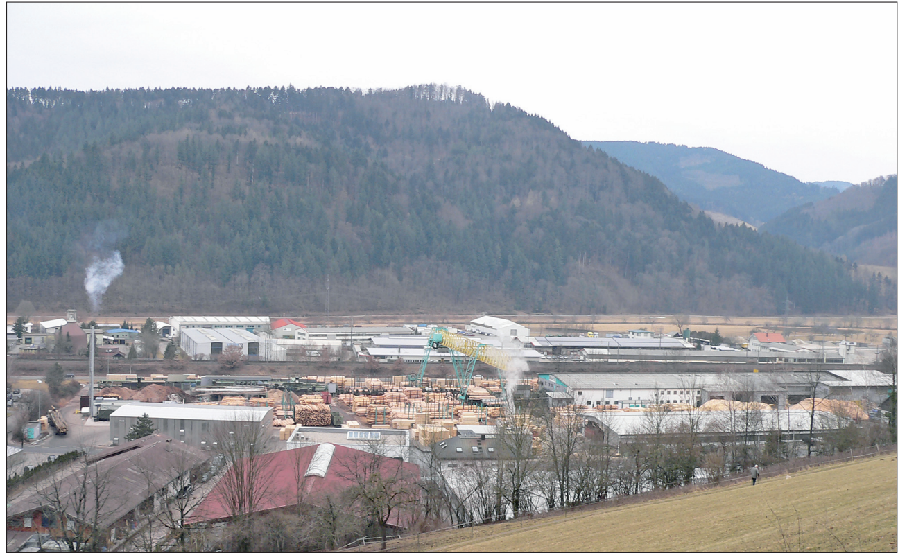
Beim Sägewerk Karl Streit in Hausach ist aufgrund der Lage Platz ein limitierender Faktor, was einer der Gründe dafür war, sich bei der Wärmeversorgung der Schnittholztrockner mit einer reinen Heizlösung im Container zu „bescheiden“.
