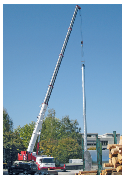
Aufbau des Kamins, der höher ist als amtlich gefordert.
