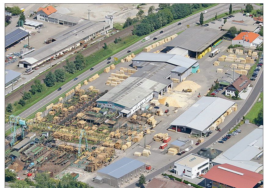
Auf dem Luftbild ist die Stelle zwischen Entrindung und Großraumtrockner zu erkennen, an der der Heizcontainer, der Schubboden und der Pufferspeicher installiert wurden (hier während der Bauphase).
