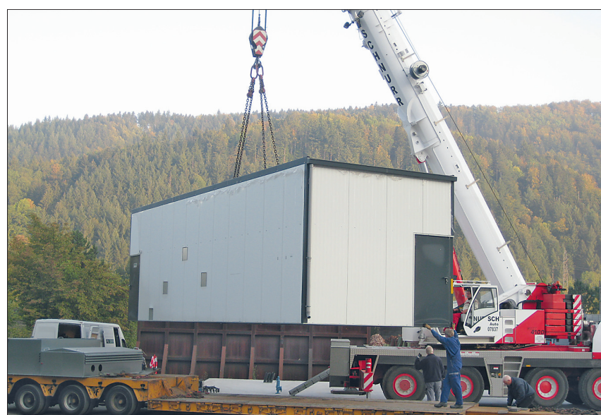
Ein leistungsfähiger Kran setzte den Container mit Kessel auf dem vorbereiteten Fundament ab.
