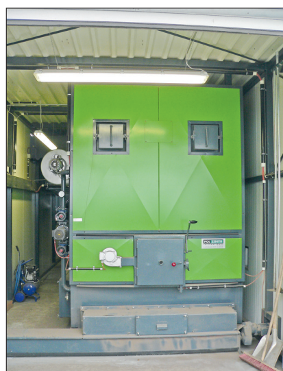
Blick in den Container: der Stufenrostkessel leistet 850 kW.
