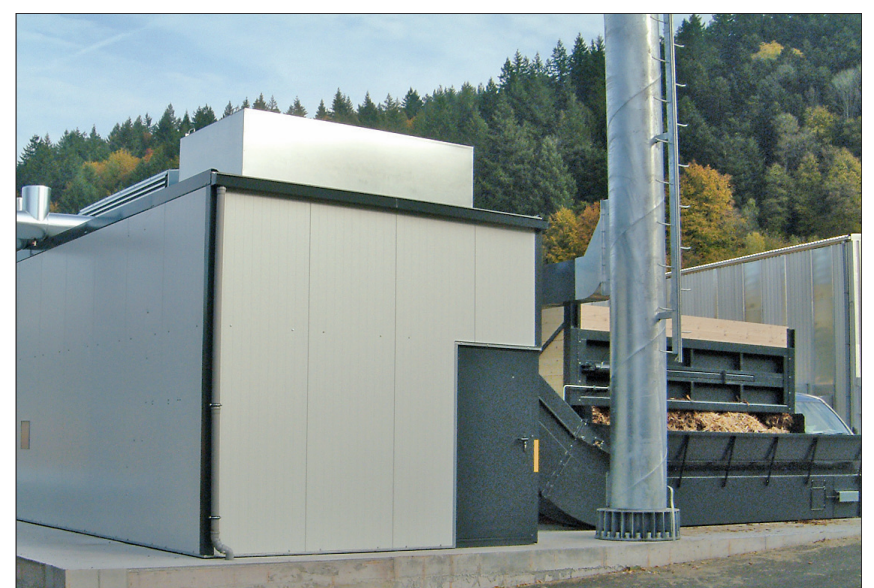
Für Aufbau und Anschluss der Gesamt-Heizanlage wurden lediglich zwei Tage benötigt.
