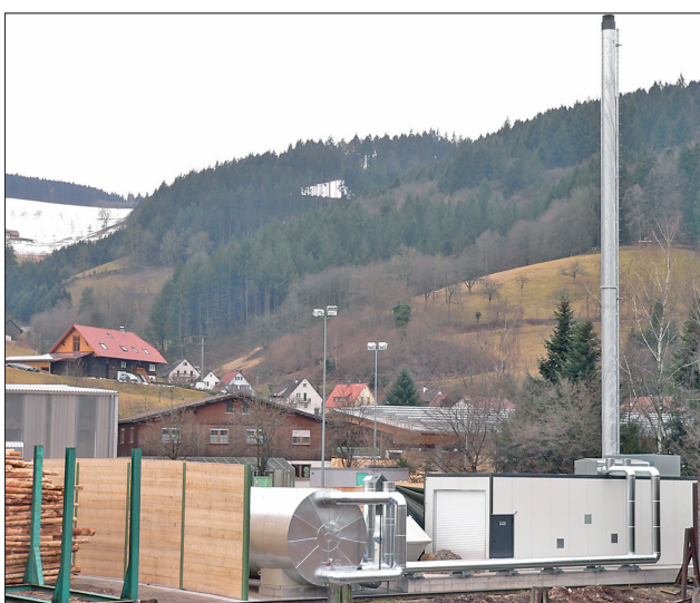
Container für Kessel und Steuerung, rechts der Kamin, links der 100 000-l-Pufferspeicher
