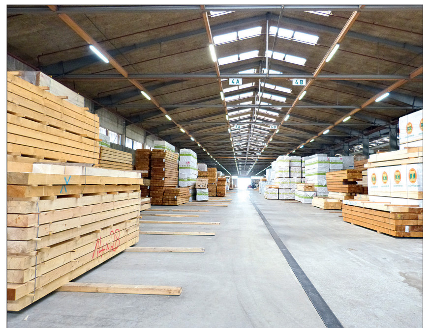
Zu den wichtigsten Bereichen, in denen Wärme benötigt wird, gehört die 180 m lange und 45 m breite KVH-Halle, die komplett mit einer Fußbodenheizung beheizt wird.
