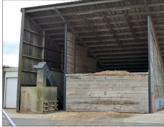
Die Entschung beim älteren Heizkessel erfolgt noch per Schnecke und Trogförderer in einen Zwischenbehälter.
