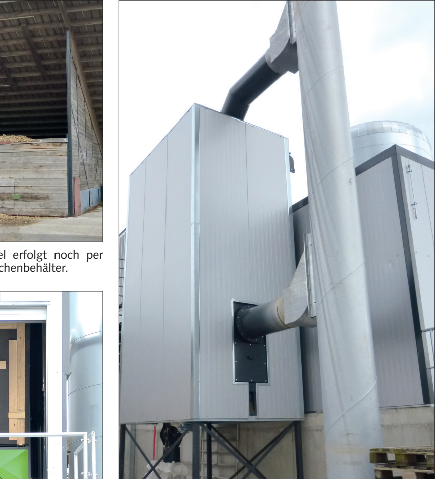
Für saubere Luft aus dem Kamin (rechts) sorgt ein von Polzenith gebauter Schlauchfilter.
