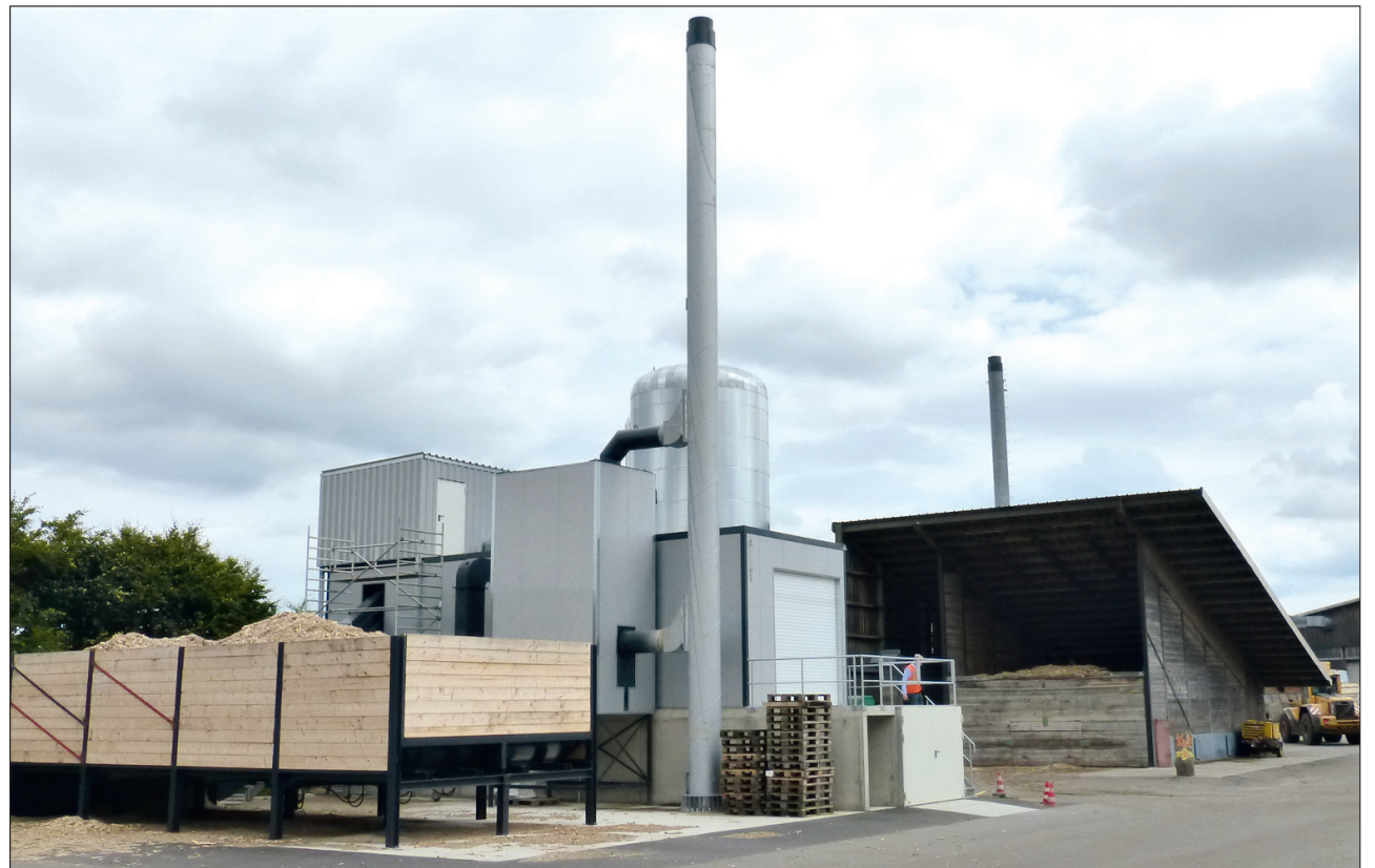
Mit der Inbetriebnahme der neuen Anlage im Mai versorgen nun zwei Polzenith-Kessel Holz Ruser mit Wärme.
