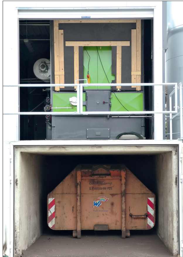
Beim neuen Kessel fällt die Asche ohne Fördertechnik direkt in einen Transportcontainer. Damit entfallen mögliche Störquellen und das Umladen der Asche.
